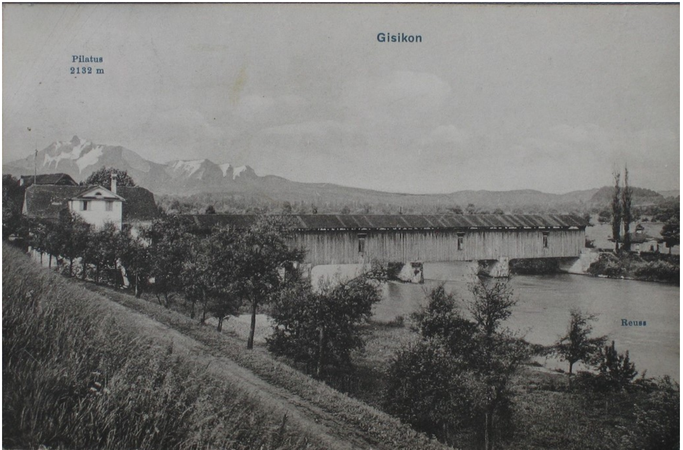
Die Brücke in Gisikon (vermutlich um 1900), Bild: Privatarhiv Jürg Stadelmann, Luzern
