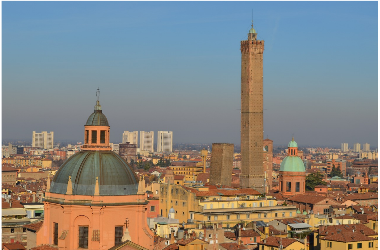
Torre Asinelli (der höhere Turm) und Torre Garisenda (der kleinere, schiefere Turm) im Herzen der Stadt Bologna
