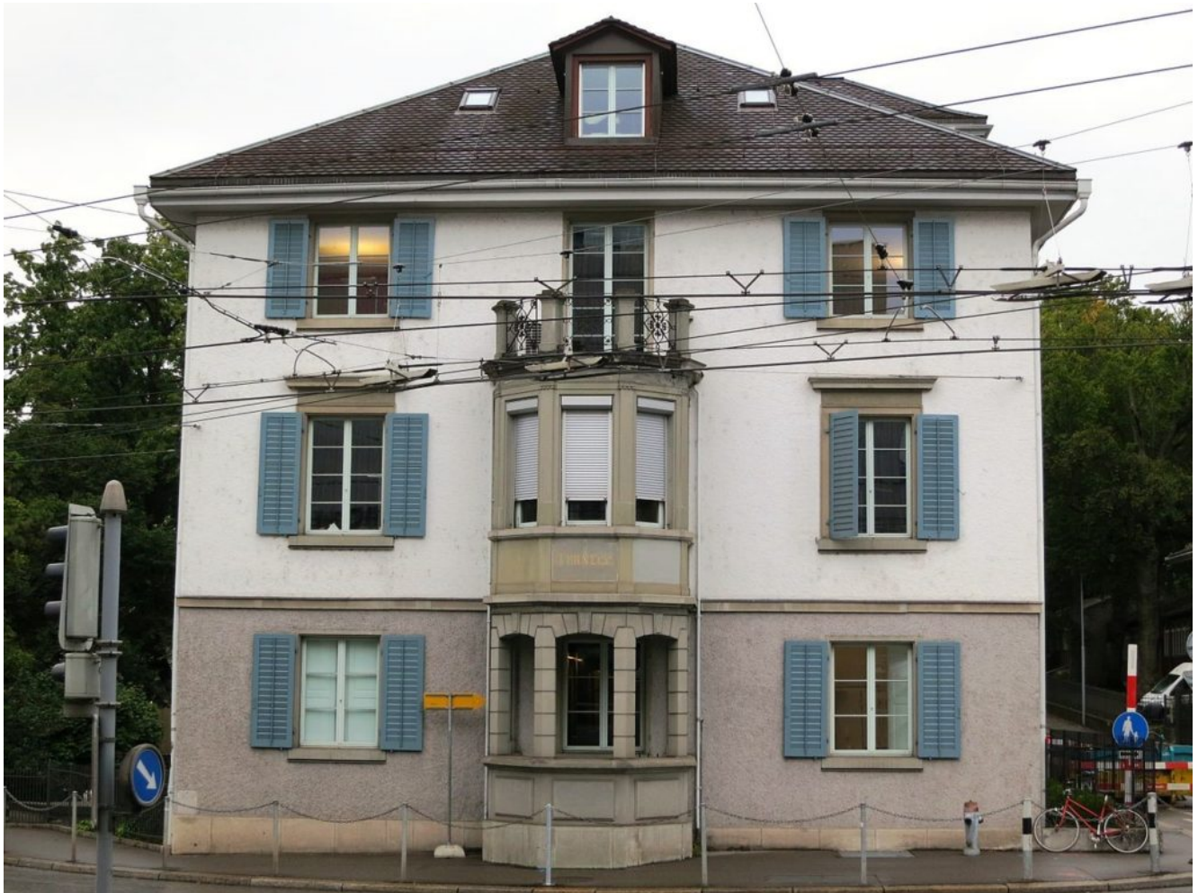
Haus Turnegg, ehemaliges HPS Zürich-Fluntern (Wikipedia)
